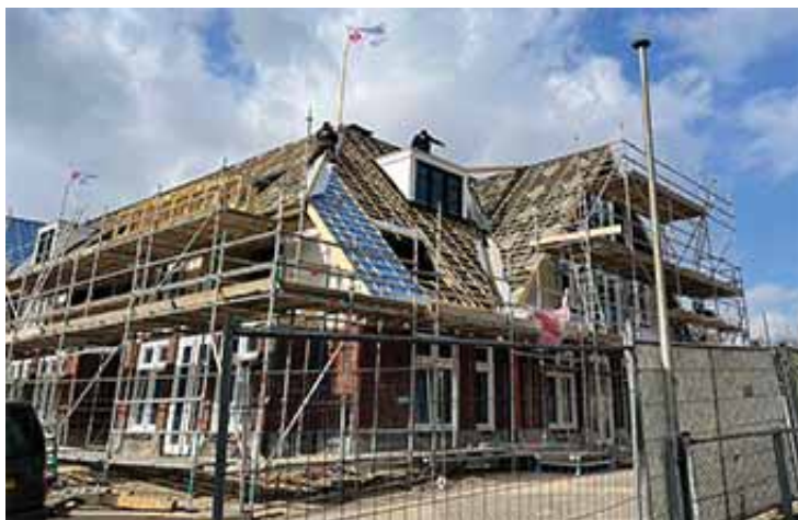
Nieuwbouw Laarderweg Eemnes
